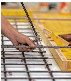
Arbeitsschritte: Vom Zusammenbauen der Armierung (links) über das Mischen des Betons und die Zugabe von Zusatzstoffen, über das Glattstreichen des noch flüssigen Betons bis zur Oberflächenbehandlung des fertigen Bauteils.
